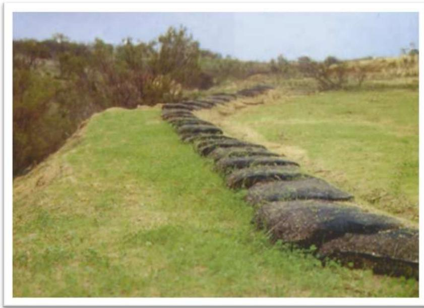
Figura 11. Método de control de erosión con sacos rellenos de tierra
