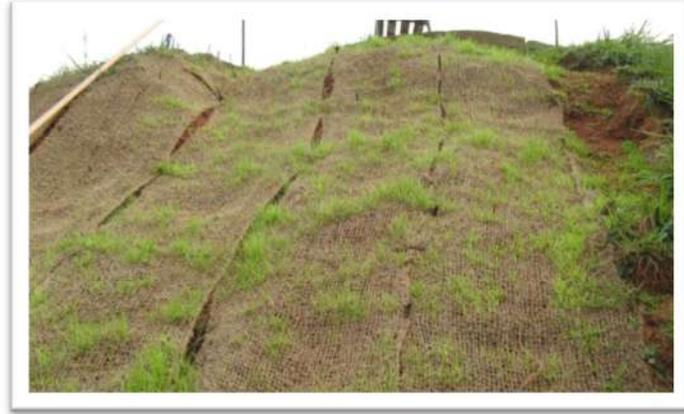
Figura 14. Método de control de erosión con cubierta superficial con ramas.
